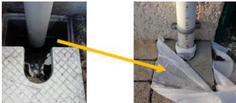
Exemple d'obturation par un voile moustiquaire
