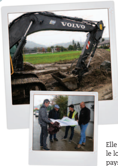
1 ÈRE RÉUNION DE CHANTIER, fin octobre, pour lancer les travaux.
