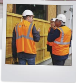
LA SALLE DES FÊTES en cours de rénovation.
